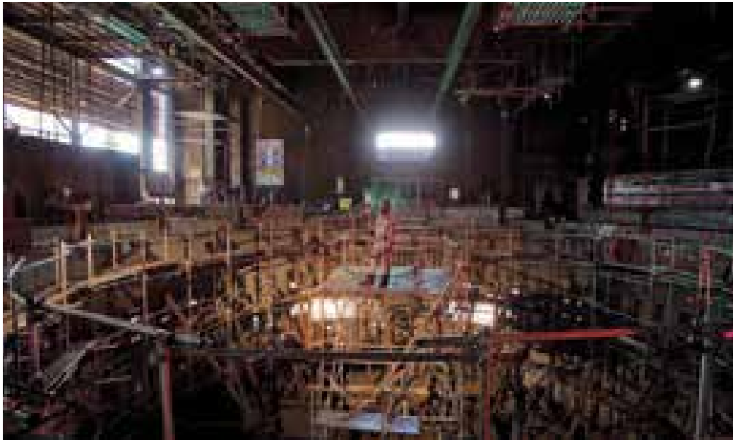
Konstruksi Furnace-4 sebagai bagian dari Proyek Perluasan Pabrik Feronikel Pomalaa
