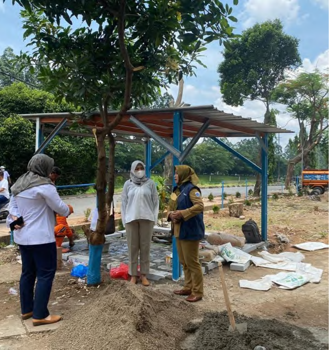
Gambar 5. Peninjauan pembangunan pada pengadaan infrastruktur publik di Kelurahan Duren Sawit
