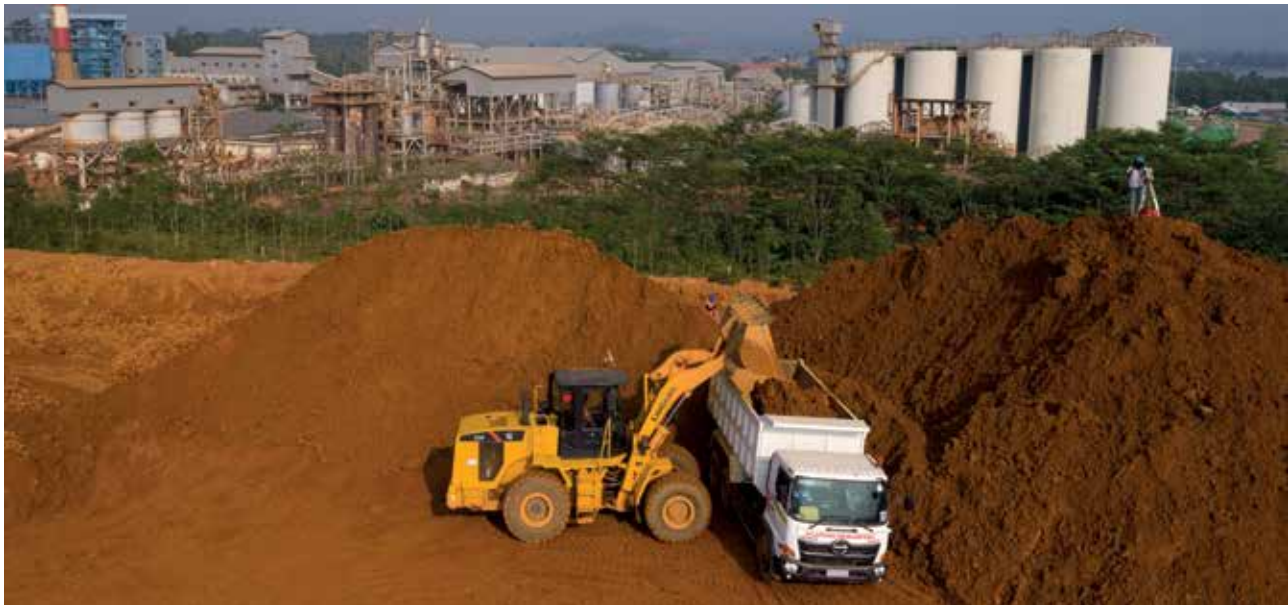
Fasilitas Tambang Bauksit dan Pabrik CGA yang Terintegrasi di Tayan Integrated Bauxite Mine & CGA Plant Facility in Tayan
