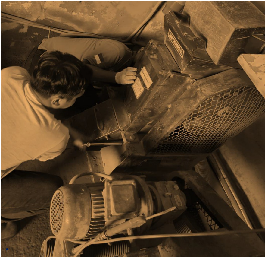
Gambar 6. Pemasangan box dust collector system pada alat crusher
