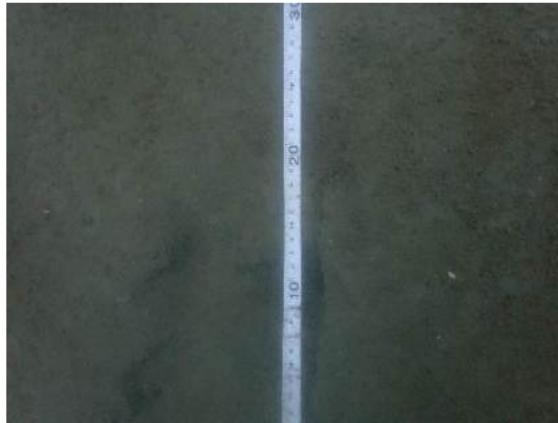
Gambar 4. 85 Kondisi substrat pada PLTU AL 3.
